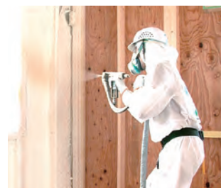
fig.08 壁への吹付け
