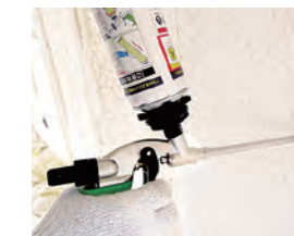
fig.17 補修にも1液性ウレタンフォーム
