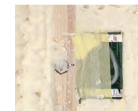
fig.21 剥離材と養生テープを活用
