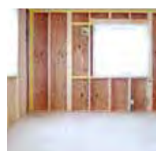
吹付けスペースを確保
