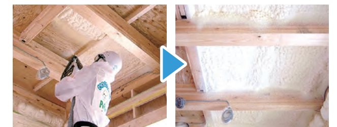
fig.03 吹付けの様子
