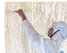
fig.16 計測器で厚みをチェック
