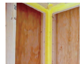
fig.20 入隅には養生テープが便利
