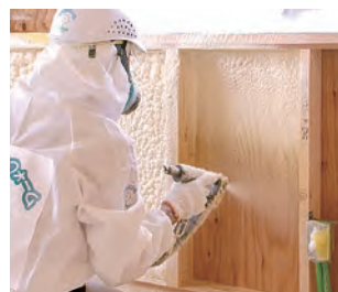
fig.07 腰壁への吹付け
