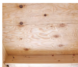
fig.09 外気に接する床の下地
