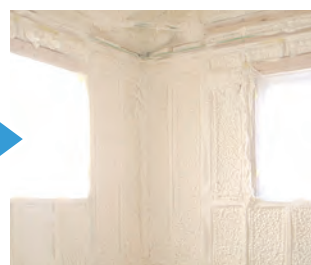
fig.06 吹付け施工後
